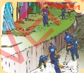
a limpeza de valas de drenagem.
